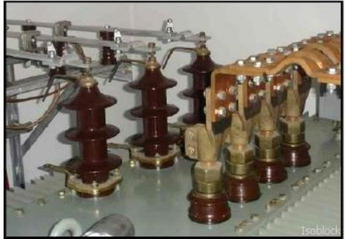
Die Bilder zeigen anschaulich die Trafo-Anschlüsse vor und nach der Wartung. Im Rahmen einer Wartung werden selbstverständlich sämtliche Komponenten, wie Schalter, Anschlüsse, Netzschutzeinrichtungen, Transformatoren etc. gereinigt und überprüft.
